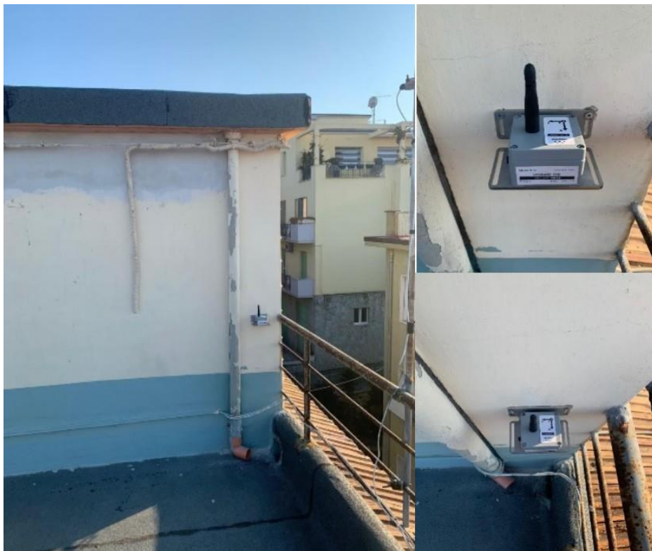
Fig. 2 - Collocazione in situ degli accelerometri.
