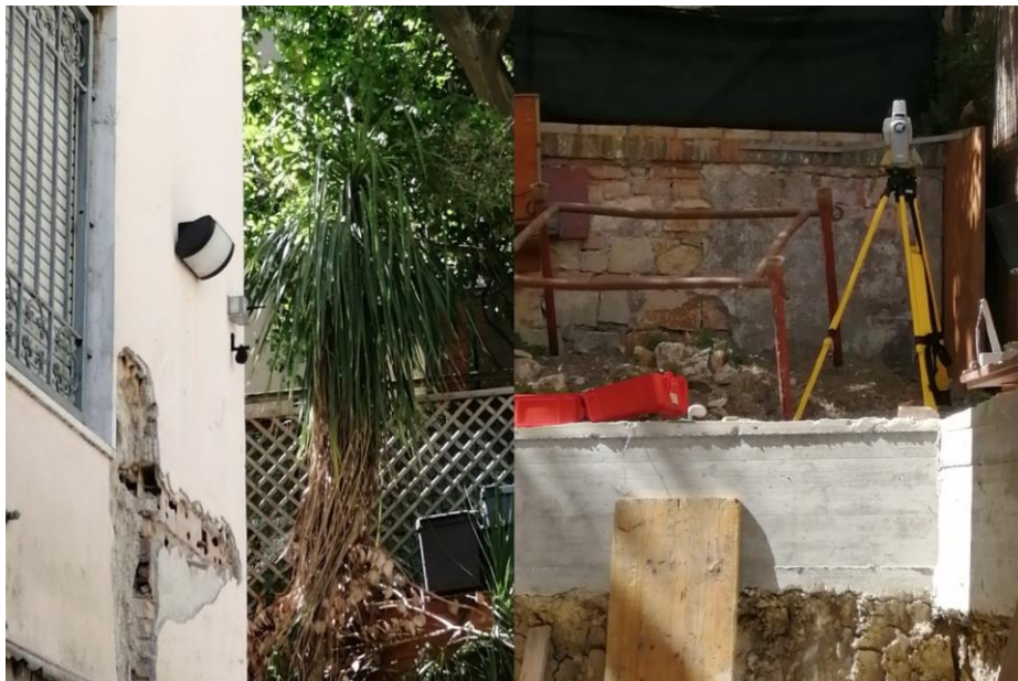
Fig. 11 - A sinistra lo stato di un nodo della struttura. A destra una delle postazioni di misura.
